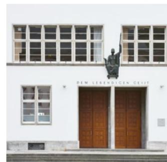
Le finestre sviluppate nell'ambito del movimento di architettura moderno "Neues Bauen" seguono il principio "form follows function". Vengono generalmente installate finestre asimmetriche con un'anta grande e una piccola e un telaio suddiviso.
