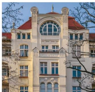
La varietà di forme e il design nella costruzione delle finestre raggiungono il loro apice nel passaggio tra Ottocento e Novecento. Finestre a due battenti con sopra-luce, trifore o finestre a cassetta con traverse nel sopra-luce sono tipiche della Germania di fine '800 (epoca Gründerzeit).
